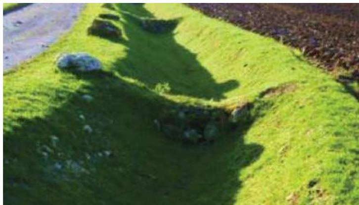
**Abbildung 41: Illustration eines Grabens mit Redent (Quelle: [www.giser.be](http://www.giser.be))**
